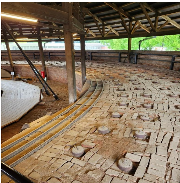
渡良瀬野木ホフマン釜2階石炭投入口
